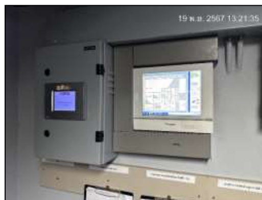
ภาพที่ 33 ระบบควบคุมไฟฟ้า Two Wire Remote
