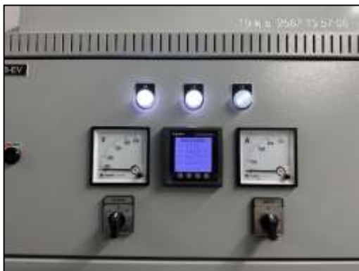
ภาพที่ 30 ชุด Power Monitoring ที่ตู้ MDB
